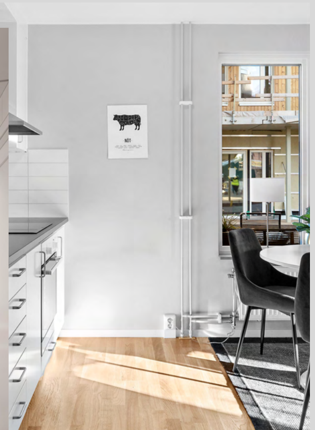
Exempel på hur en utvändig rördragning kan se ut. Dessa rör målas alltid in i väggens kulör. Sockeldosa vid betongvägg är utanpåliggande.
