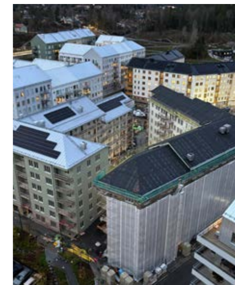
Projektet Mira & Juno sedda från balkongen på 16:e våning på Vyn. Husen byggs i Vega på uppdrag av Stena Fastigheter.
